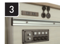
3 スwitchingパネル(照明/電源)
